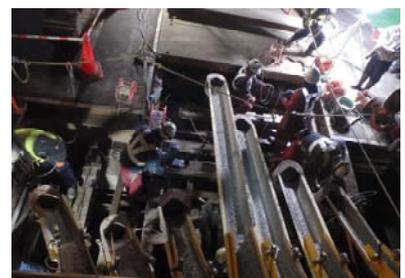
写真-2 分配器を用いた打設
