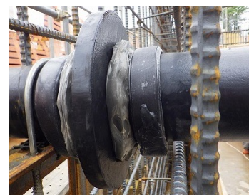
写真-3 配管まわり止水
