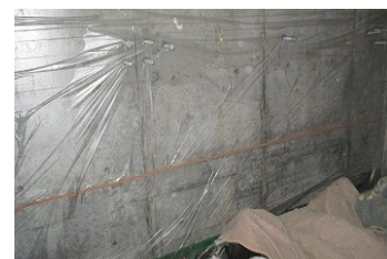
写真-4 保湿養生
