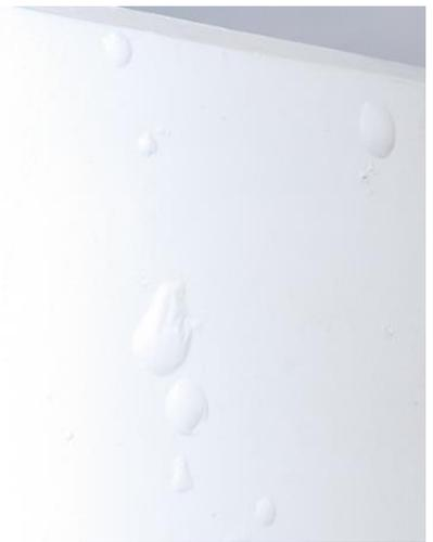
写真-1 表面被覆工法の膨れの状況
