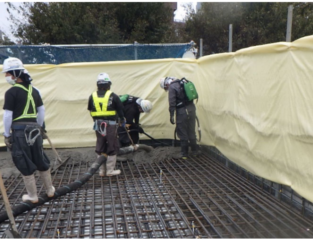
写真-2 コンクリートの打設状況
