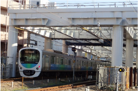
写真-1 高架橋の状況
