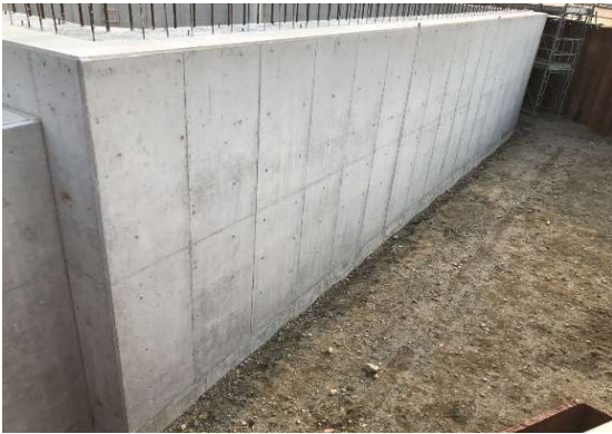
図—6 仕上がり面の状況
