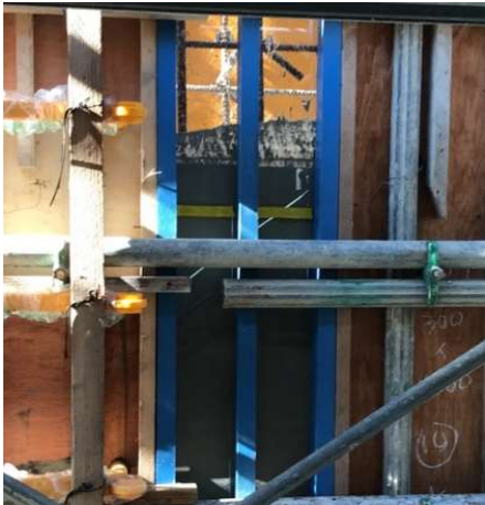
図—5 透明型枠の使用
