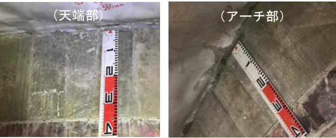
写真－3 脱型直後の充填確認
