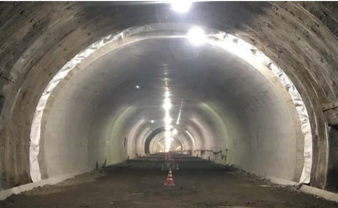
写真－4 覆工コンクリート仕上がり状況
