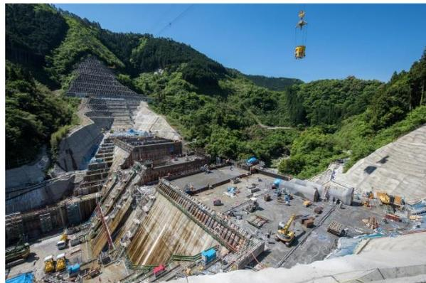
写真-2 平瀬ダムでの打設状況
