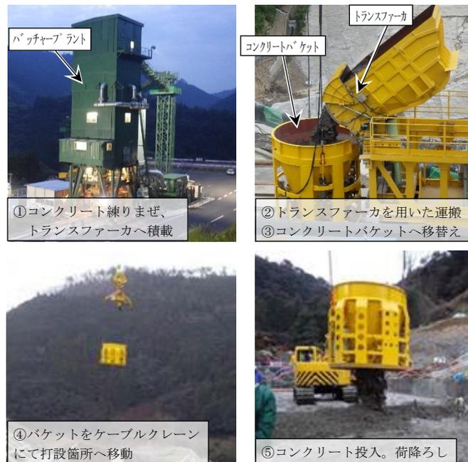
写真-1 ダムコンクリート打設フロー
