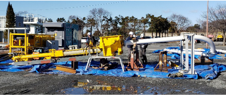
写真－3 コンクリート圧送試験状況
