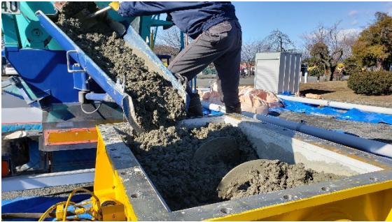
写真－4 コンクリート荷降ろし状況
