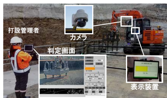
図-4 バイバックへ搭載した状況
