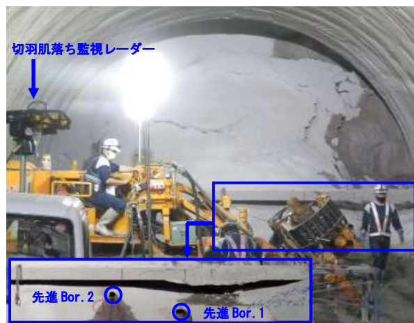
写真-2 切羽鏡面の変位計測（先進ボーリング時）
