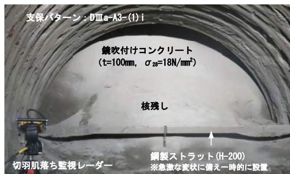
写真-1 切羽鏡面の変位計測（切羽安定対策後）
