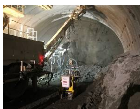
写真-4 吹付時 計測状況
