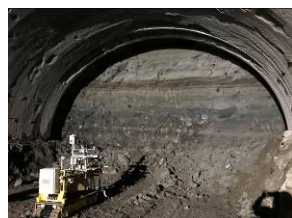
写真-3 掘削完了計測状況
