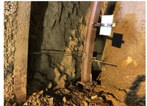
写真-4 鋼製支保工の設置状況
