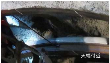
写真-5 袋体付き鋼製支保工の搭載
