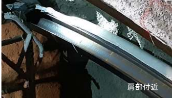
写真-6 袋体へのモルタル充填
