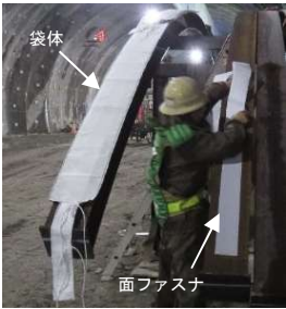
写真-4 袋体の取付け
