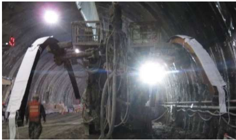
写真-5 袋体付き鋼製支保工の搭載
