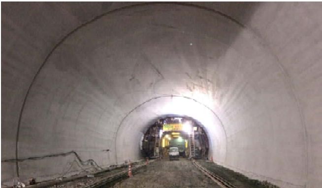
写真-4 脱型後の仕上がり状況
