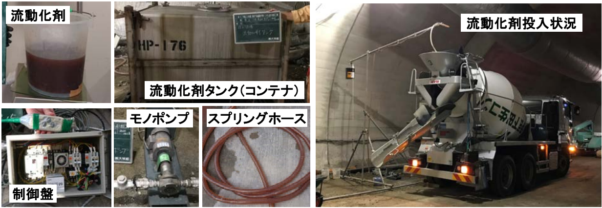
写真-2 流動化剤の投入設備の概要と投入状況
