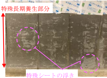
写真-5 特殊シートの存置状況
