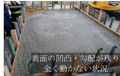
写真-2 振動中のコンクリート打上がり面
