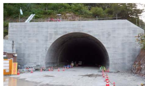
写真-2 坑門工の外観状況
