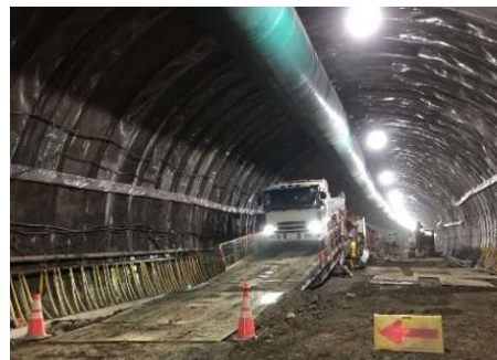
写真-1 90度回転式車輪搭載型インバート栈橋
