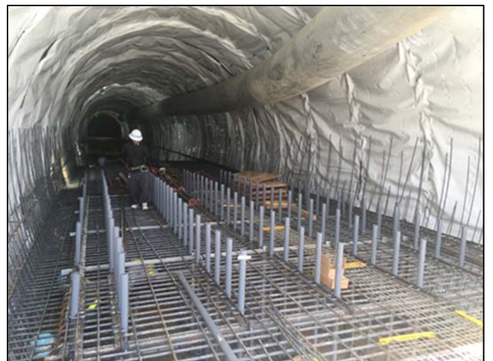
写真-1 施工状況
