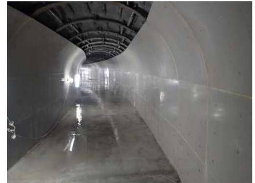
写真-4 側壁パネルライニング完了
