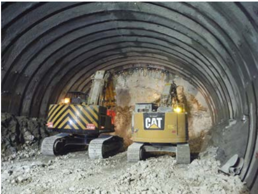
写真-1 トンネル掘削状況
