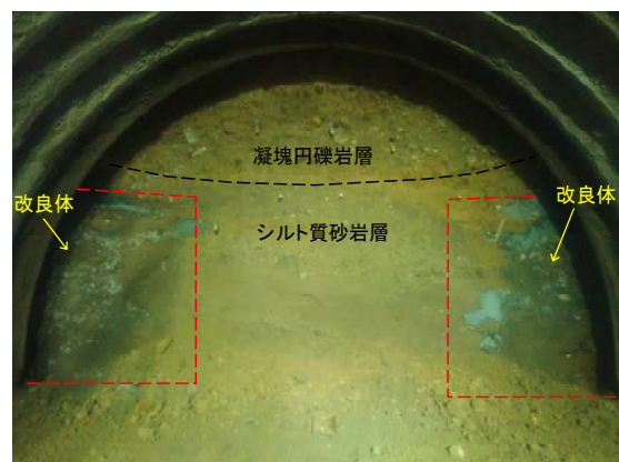
写真-1 地盤改良区間の切羽状況
