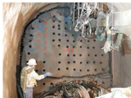
写真-1 スロット工法施工状況
