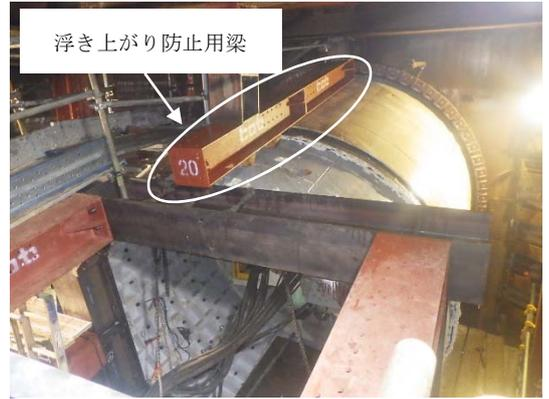
写真-4 浮き止め防止鋼材設置状況
