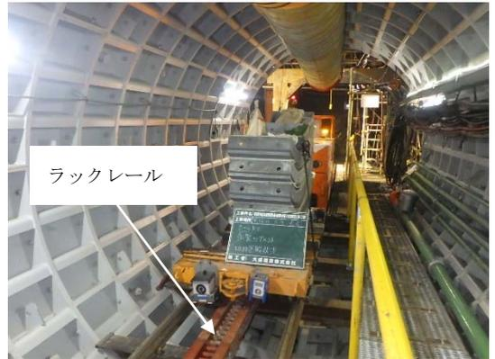
写真-5 ラック・ピニオン式軌道装置
