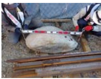
写真-2 中間立坑巨礫 1000mm×580mm×470mm
