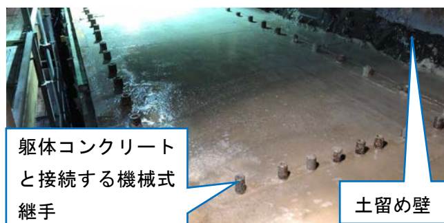
写真－3 機械式継手拡大写真（天端部）
