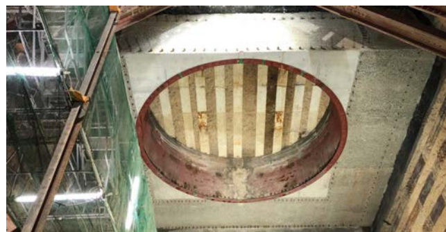
写真－2 坑口コンクリート全景写真
