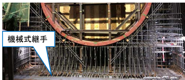
写真－1 鉄筋組立状況写真
