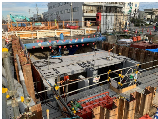
写真-2 施工状況
