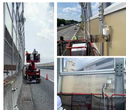
図-7 現場での測定状況
