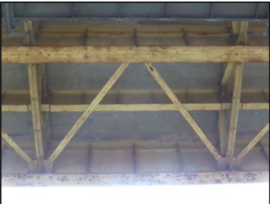
写真-1 鋼鈑桁橋
