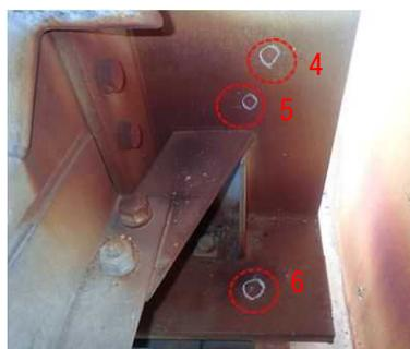
写真-4 測定箇所（劣化部）
