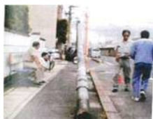
写真-1 倒壊事例 2)
