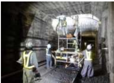
図-2 打音点検の様子
