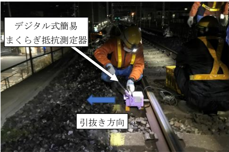
図2 道床横抵抗力試験の状況
