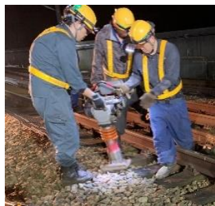
図4. 縦ランマ締固め箇所(左)と施工の様子(右)
