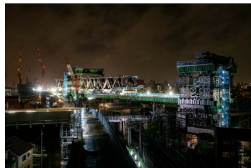
写真-2 トラス桁の送出し状況
