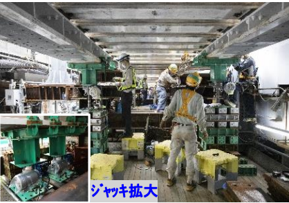
写真-2 工事桁こう上状況
