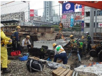
写真-1 嵩上げ鋼材設置状況
