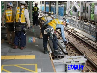
写真-3 ホーム拡幅状況
