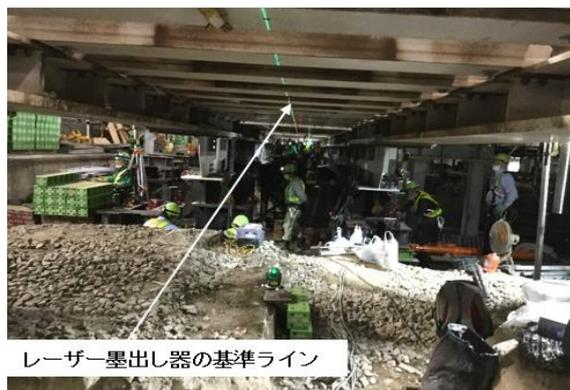
図6 レーザー墨出し器による計画軌道中心線
