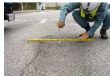
写真-1 変状測定状況
