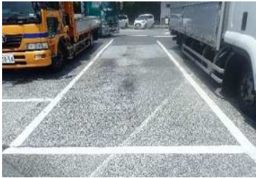
写真-2 試験施工箇所現況
