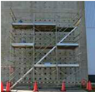
写真1 足場設置状況
