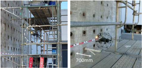
写真2 UAV撮影状況
