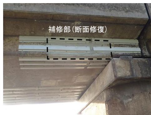
図2 小規模補修部への適用状況
