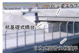
写真-3 現空港/連絡誘導路接続部
