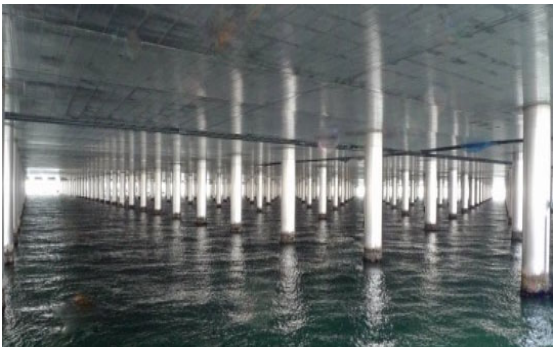
写真 1 D 滑走路のステンレス鋼ライニング
