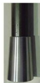
写真-1 テーパー型ナット取付状況
