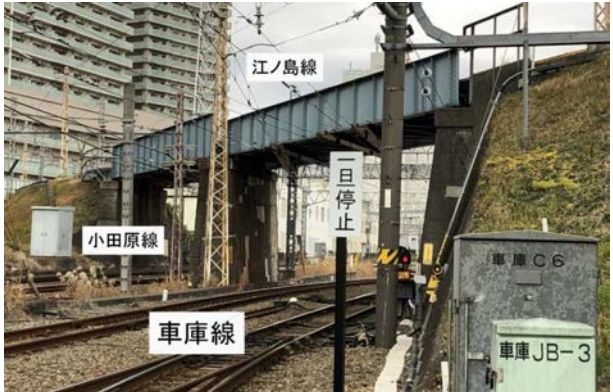
写真1 現況写真（小田原方から撮影）
