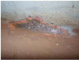
写真-1 溶接表面腐食
