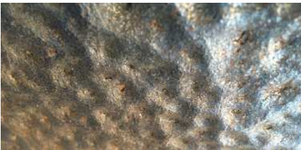
写真-5 一次素地調整工施工後
