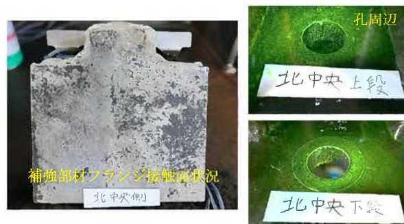
図 9 補強部材状況
