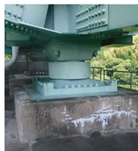
写真1 既設の鋼製支承
