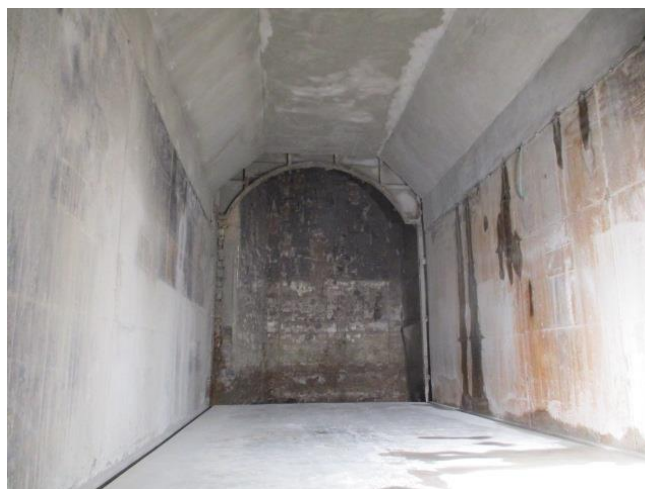
写真-9 施工完了
