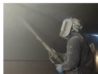
写真-8 乾式吹付
