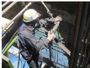
写真-5 はつり状況
