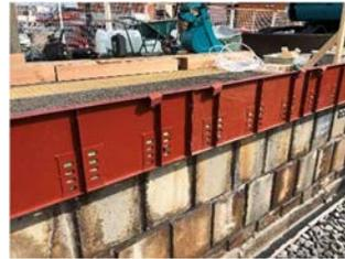
写真1 型枠設置状況
