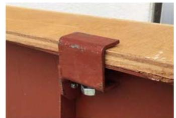
写真2 飛散防止抑え金具
