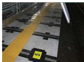
写真6 FRP床板取付完了
